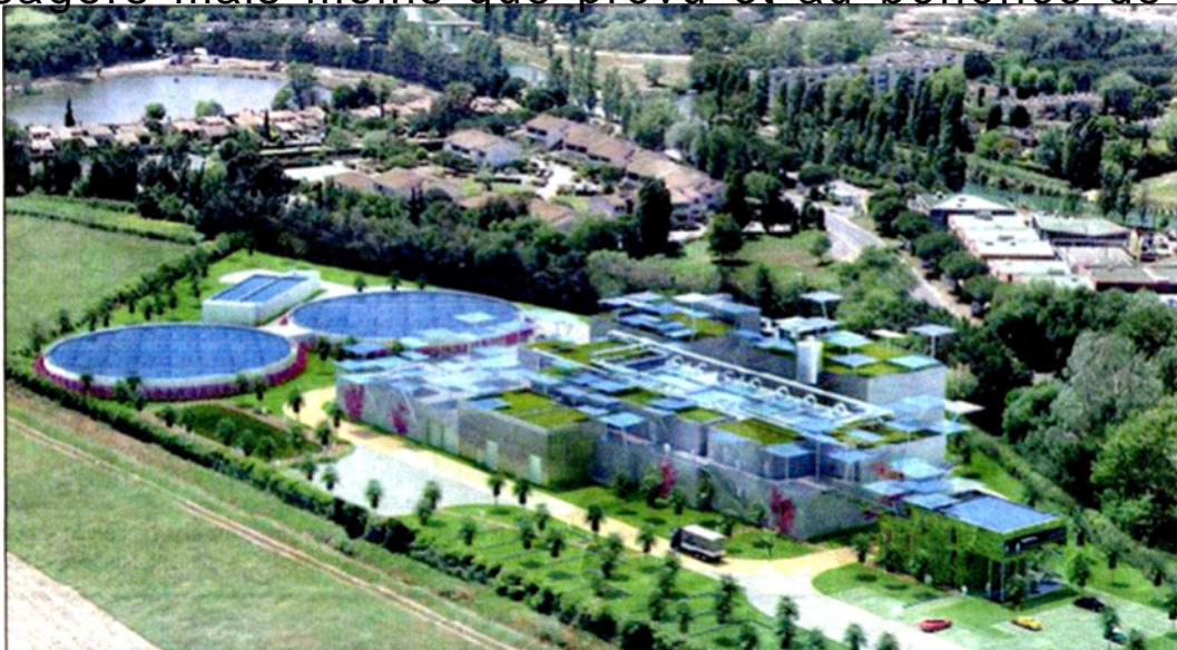
Vue aérienne de la station d'épuration dans son environnement avec 4000 m 2 de panneaux solaires sur les toits. (Photo D.R.)
